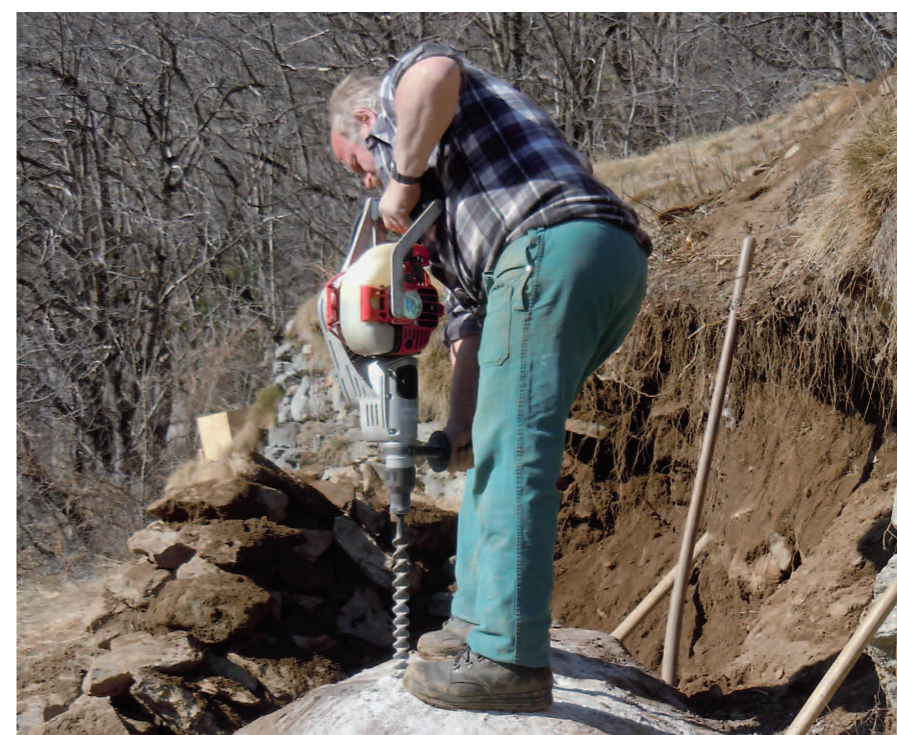
Travaux pendant la reconstruction des murs des pierres sèches
