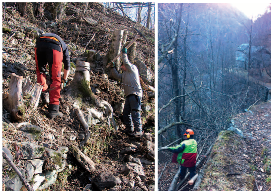
Arbeitnehmer entfernen die Wurzeln von Trockenmauer entlang des Weges. Schneiden von Bäumen entlang des Saumpfades.
