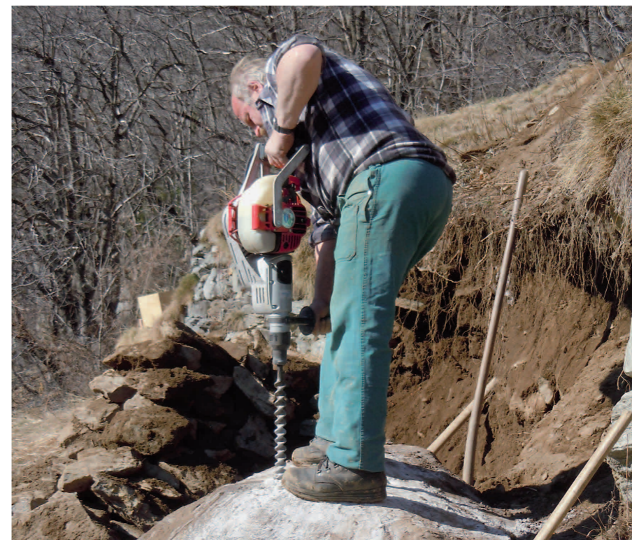
Arbeiten während des Wiederaufbaus von Trockenmauern.
